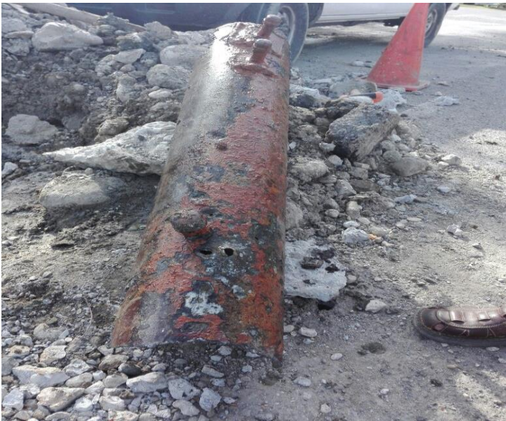
Tubería sustituida en Playa Dorada
