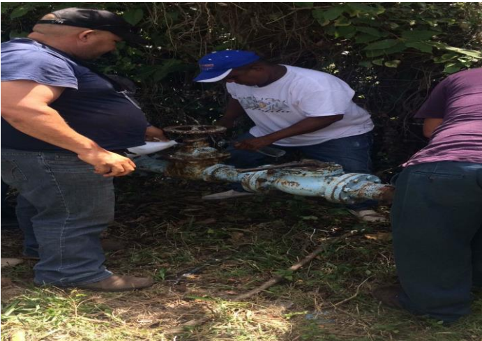
Mantenimiento de Válvula en Vuelta Larga
