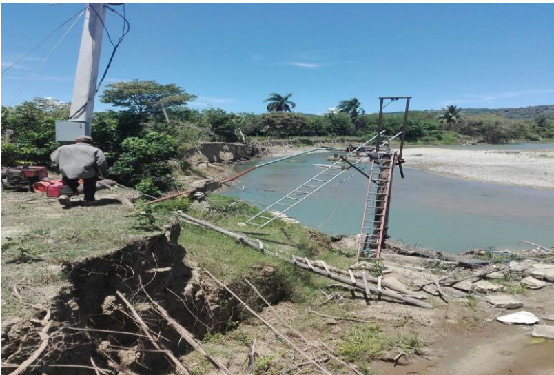
Preparación de Plataforma, para extraer una Bomba en Candelón.
